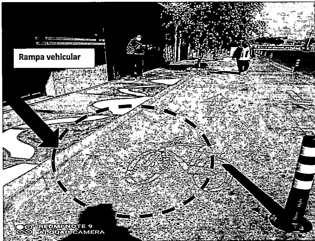
IMAGEN N° 4 PINTADO DE PICTOGRAMA E INSTALACIÓN DE EQUIPOS PARA CICLOVÍAS SIN HABER REALIZADO LA LIMPIEZA Y RETIRO DE INFRAESTRUCTURA EXISTENTE TRAMO: AV. TARATA CON AV. INDUSTRIAL
