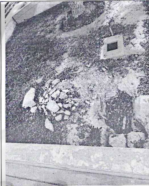
Imagen n° 65: Presencia de material desmonte, caja de concreto de agua rota y caja de concreto de agua sin tapa.
