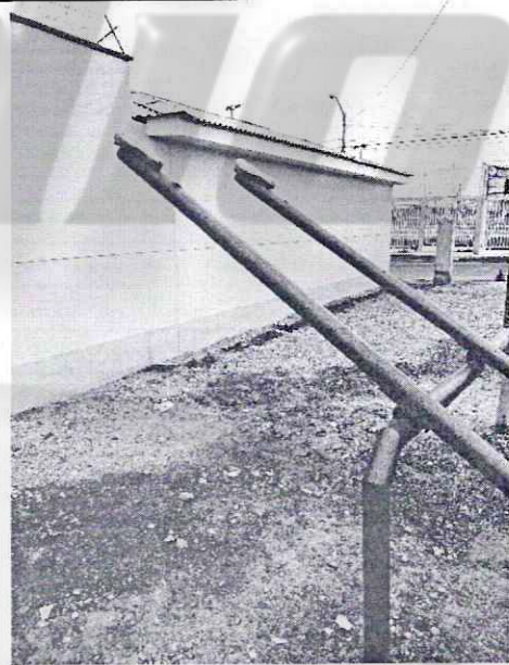
Imagen n° 58: Juegos infantiles en mal estado y presencia de oxido.
