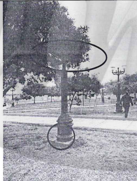
Imagen n° 47: Poste sin farola y sin tapa de registro.
