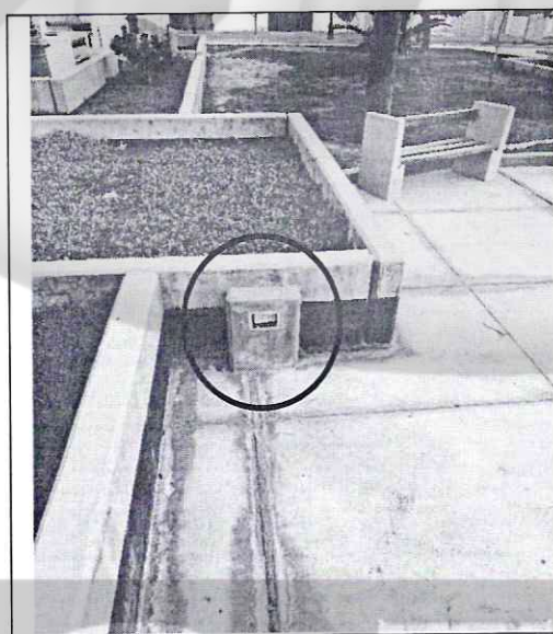
Imagen n° 95: Tomacorriente suelto.
