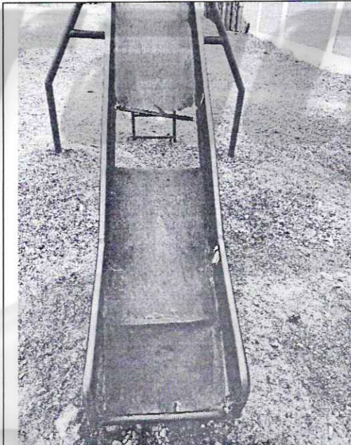
Imagen n° 57: Juegos infantiles en mal estado (con gran orificio) y presencia de oxido.
