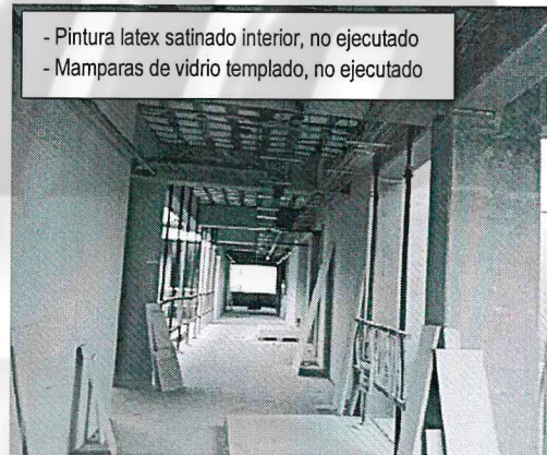
FOTOGRAFÍA N° 14 CORREDOR DE 7MO NIVEL - EDIFICIO CENTRAL
