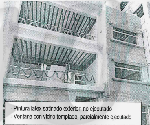
FOTOGRAFÍA N° 16 FACHADA INTERIOR DE EDIFICIO PET
