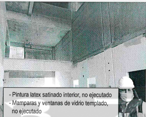
FOTOGRAFÍA N° 5 RECEPCION 1ER NIVEL DE EDIFICIO CENTRAL
