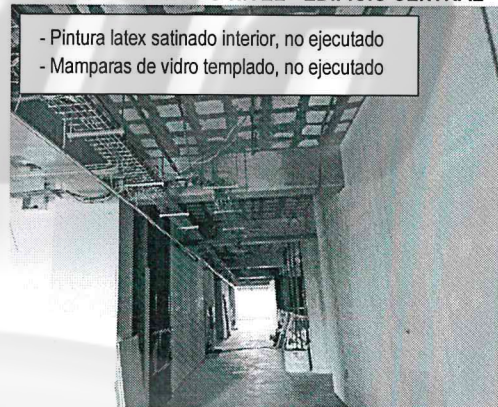
FOTOGRAFÍA N° 8 CORREDOR DE 2DO NIVEL - EDIFICIO CENTRAL
