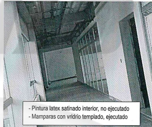
FOTOGRAFÍA N° 20 CORREDOR 2DO NIVEL DE EDIFICIO PET
