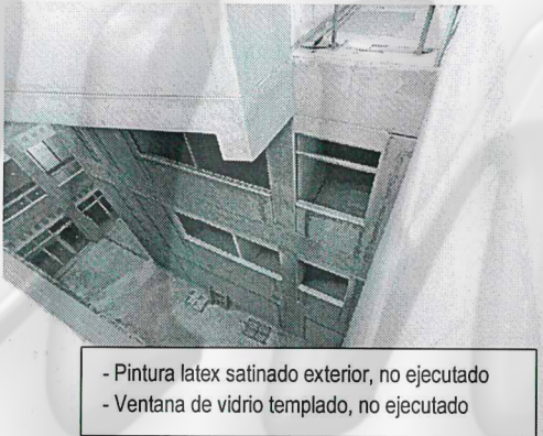
FOTOGRAFÍA N° 3 LATERAL DE EDIFICIO CENTRAL
