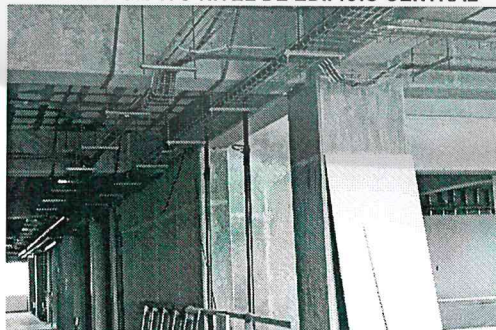
FOTOGRAFÍA N° 11 CORREDOR 4TO NIVEL DE EDIFICIO CENTRAL
