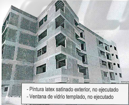
FOTOGRAFÍA N° 1 FACHADA POSTERIOR DE EDIFICIO CENTRAL
