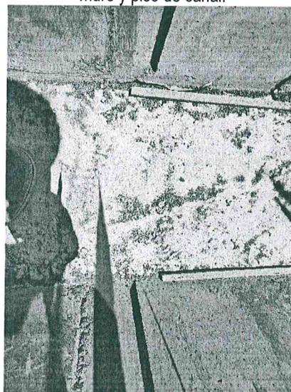
Asimismo, se advirtió que el sello eslatomerico aplicado en varias de las juntas ejecutadas, tendría un espesor menor al señalado en el expediente técnico.
