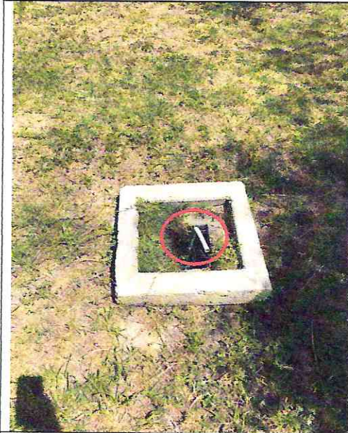
Imagen n° 148: Caja de concreto de agua sin tapa y tubería expuesta.
