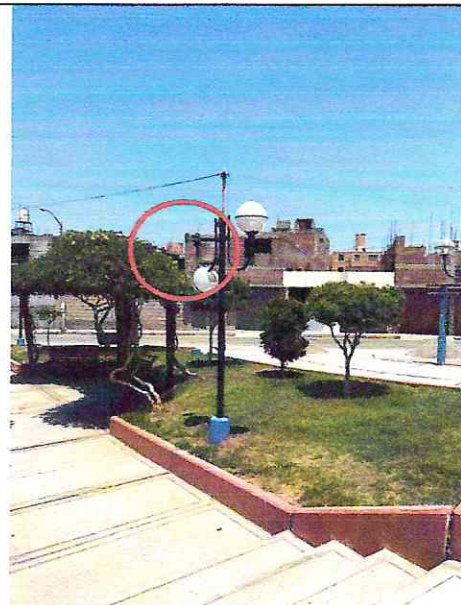
Imagen n° 157: Poste de luz sin farola y sin luminaria.
