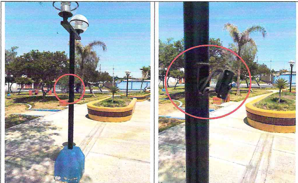
Imagen n° 146: Poste de luz sin tapa de caja de registro, con cables expuestos.
