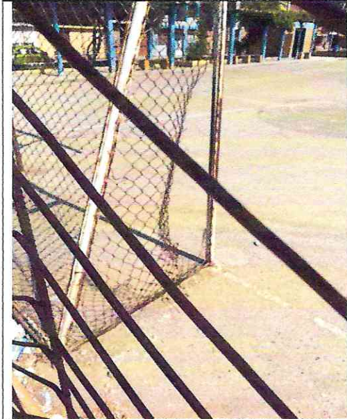
Imagen n° 104: Arco metálico de losa deportiva roto y oxidado.
