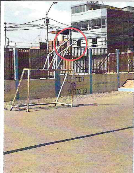
Imagen n° 74: Estructura deportiva múltiple oxidada, sin malla metálica y sin tablero de baloncesto.
