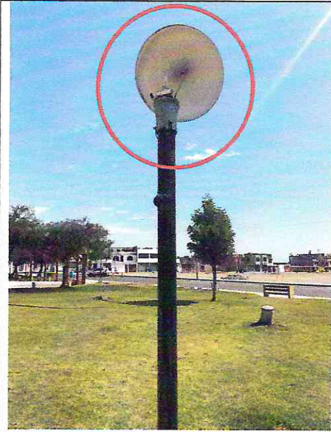
Imagen n° 47: Poste de luz sin farola y sin luminaria.
