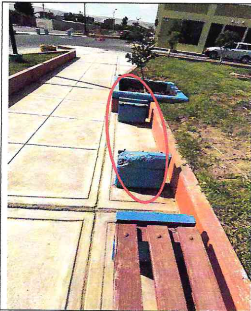
Imagen n° 69: Bancas de concreto rotas y jardineras despintadas.
