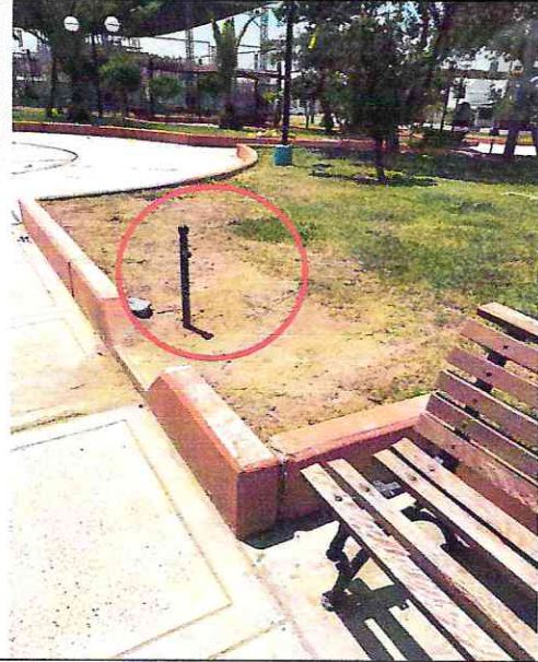
Imagen n° 158: Estructuras de metal sin tacho de basura y jardineras de concreto despintadas.
