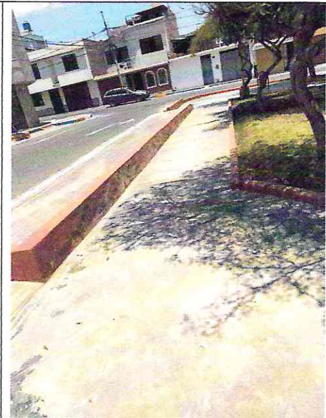
Imagen n° 113: Sardineles de concreto despintados y veredas de concreto con fisuras y desgaste
