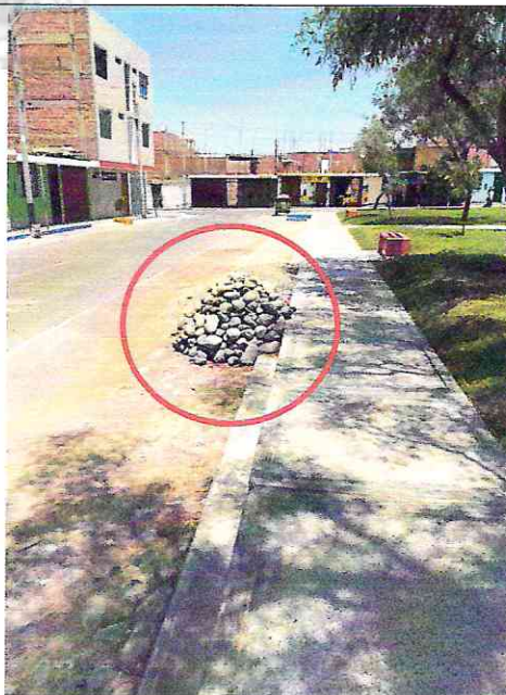
Imagen n° 167: Presencia de material de desmonte.
