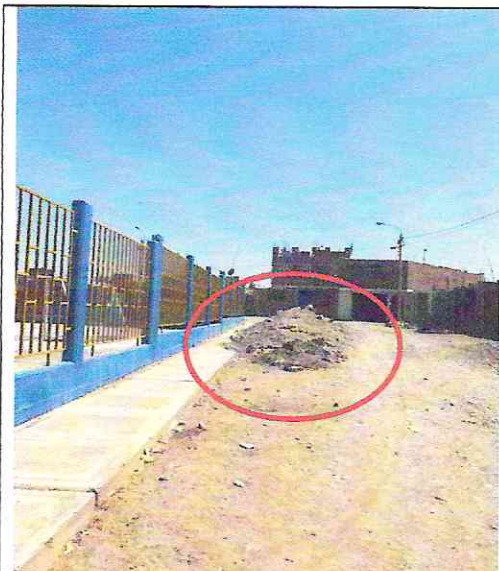
Imagen n° 29: Presencia de material de desmonte y basura.
