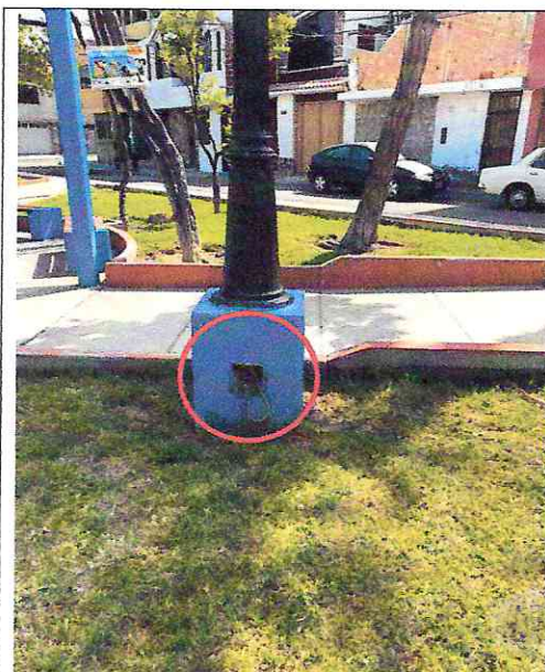
Imagen n° 96: Poste de luz sin tapas de registros con cables expuestos.
