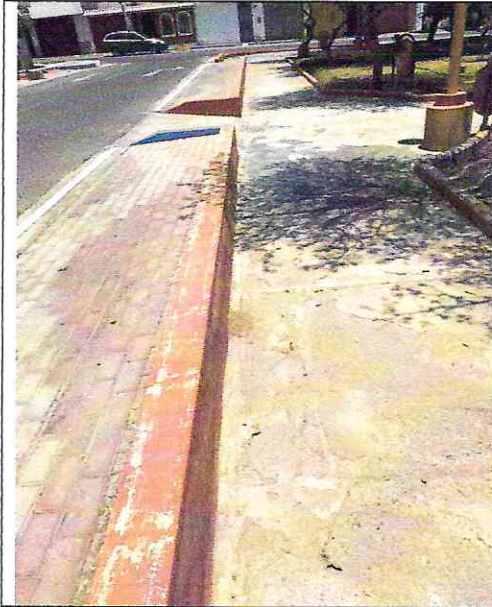
Imagen n° 112: Sardineles de concreto despintados y veredas de concreto con fisuras y desgaste
