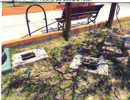
Imagen n° 42: Sin tacho de basura y cajas de concreto de agua sin tapa.
