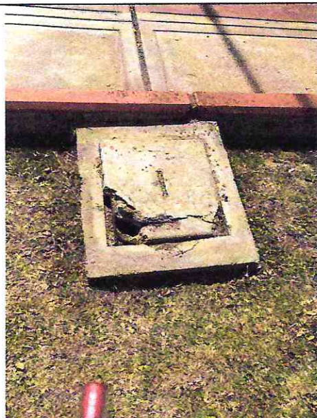
Imagen n° 124: Caja de concreto de agua con la tapa rota.
