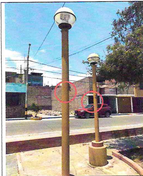
Imagen n° 116: Postes de luz con caja de registro suelta.
