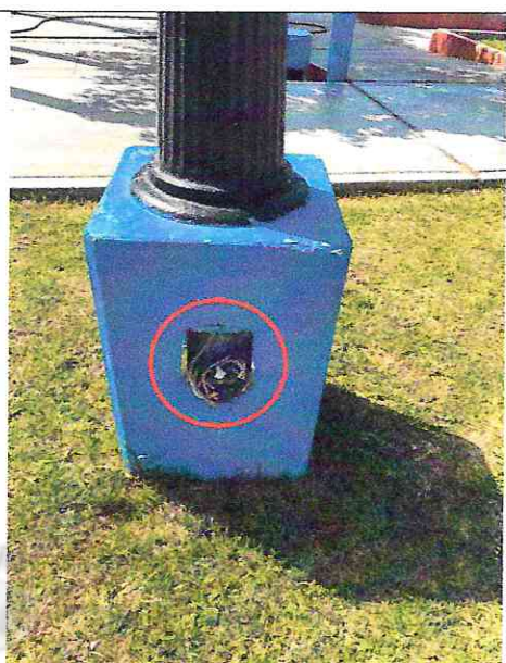
Imagen n° 97: Poste de luz sin tapas de registros con cables expuestos.
