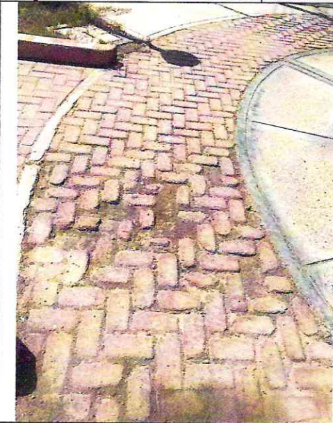
Imagen n° 122: Adoquines de concreto coloreados de caminarias rotos y desgastados.
