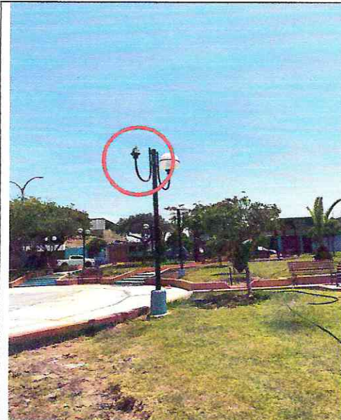
Imagen n° 156: Poste de luz sin farola y sin luminaria.
