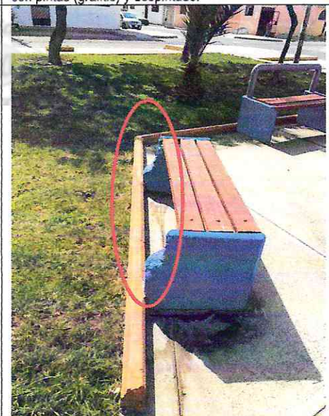
Imagen n° 64: Banca de concreto con ausencia de espaldar.
