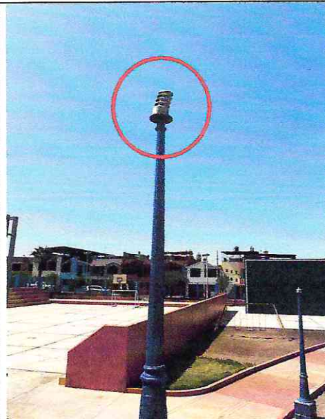
Imagen n° 125: Poste de luz sin farola y luminaria rota.
