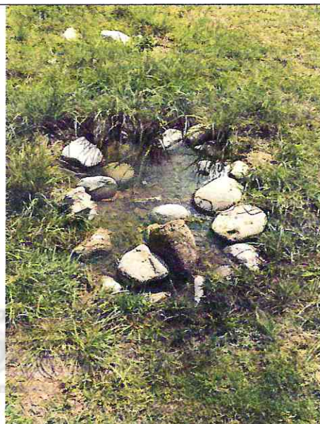
Imagen n° 58: Carencia de caja de agua y fuga.
