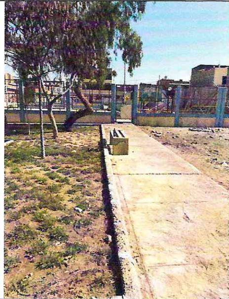
Imagen n° 81: Veredas de concreto en mal estado, jardineras de concreto y bancas despintadas.
