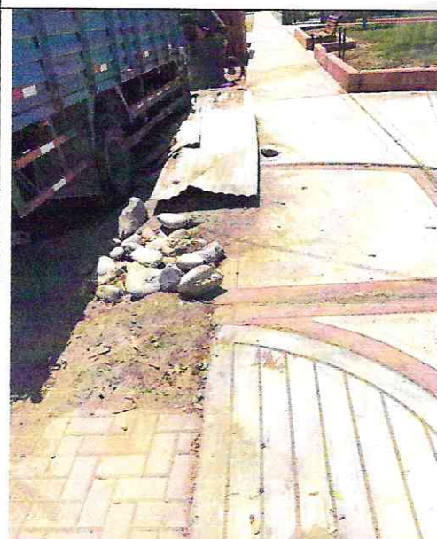
Imagen n° 162: Presencia de material de desmonte y basura.
