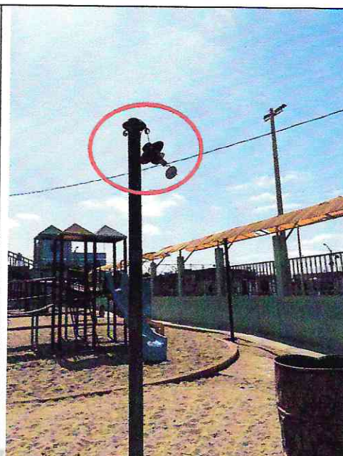
Imagen n° 6: Poste de luz sin farola, luminaria rota.
