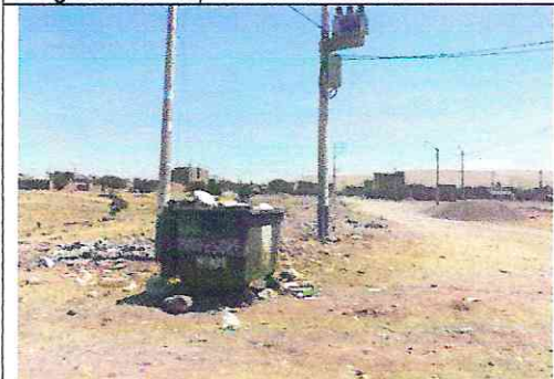
Imagen n° 37: Presencia de basura.
