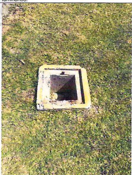
Imagen n° 139: Caja de concreto sin tapa.
