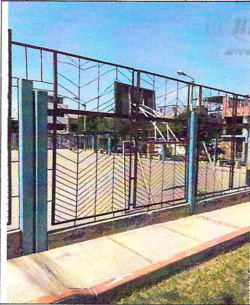
Imagen n° 102: Sobrecimiento de cerco perimétrico con presencia de sulfatos y despintado.
