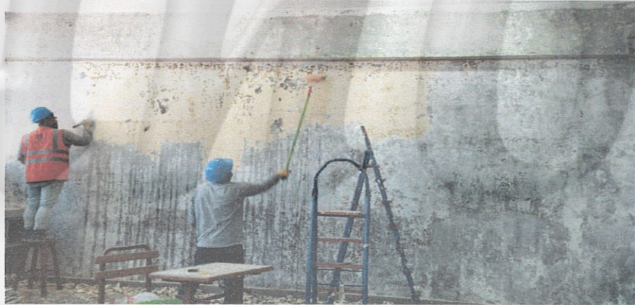
Imagen N° 3 Rasqueteo de muros utilizando balón de gas (manchas negras por quemado de pintura)
