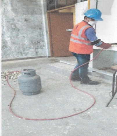
Imagen N° 2 Manipulación de balón de gas para rasqueteo de muros
