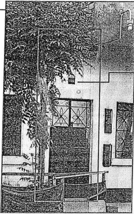
Infraestructura arquitectónica del inmueble de la Jr. Chiquian N.º 2432 Int. 3 – El Agustino – Lima.
