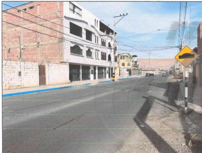
IMAGEN N° 12 ESTADO ACTUAL DE SEÑALIZACIÓN HORIZONTAL Y VERTICAL PARA RESALTO VEHICULAR UBICADO EN PROGRESIVA 1+300
