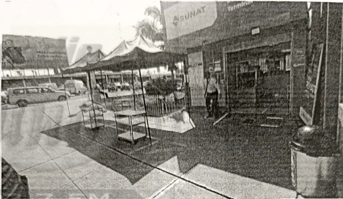
FOTO N°03 En el hall externo se observa toldos y mesas al colindante de oficina de Sunat, en medio de la vía de evacuación.
