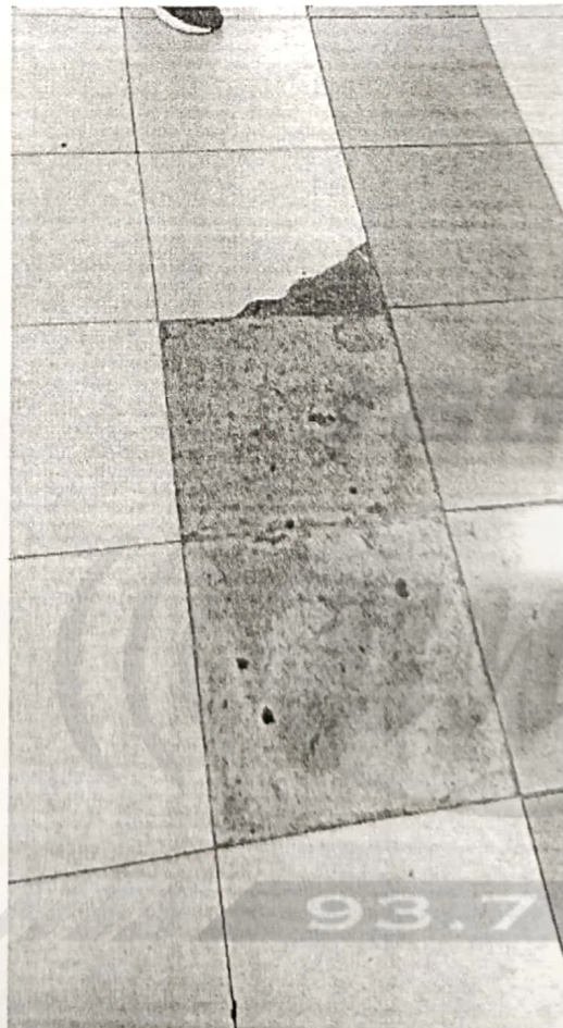
FOTO N°04 Se observan cerámicos agrietados y con partes faltantes.
