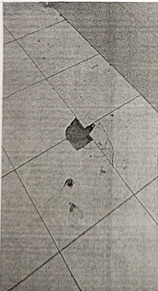
FOTO N°04 Se observan cerámicos agrietados y con partes faltantes.
