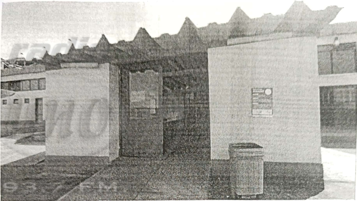
FOTO N°14 Falta señalización de Salida.
