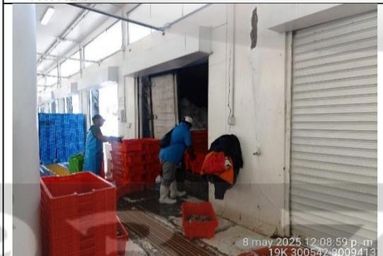
Fotografía n.º 35: Vista desde el interior de puerta de embarque, se observa rajadura y desprendimiento de concreto producto de los choques a la puerta de embarque.
