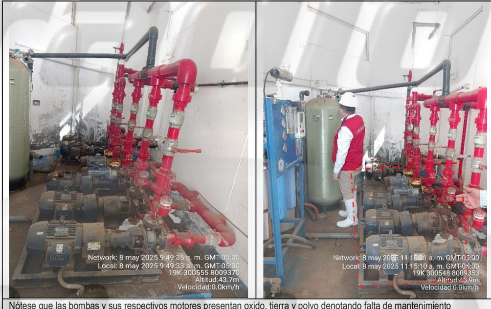
Nótese que las bombas y sus respectivos motores presentan oxido, tierra y polvo denotando falta de mantenimiento
