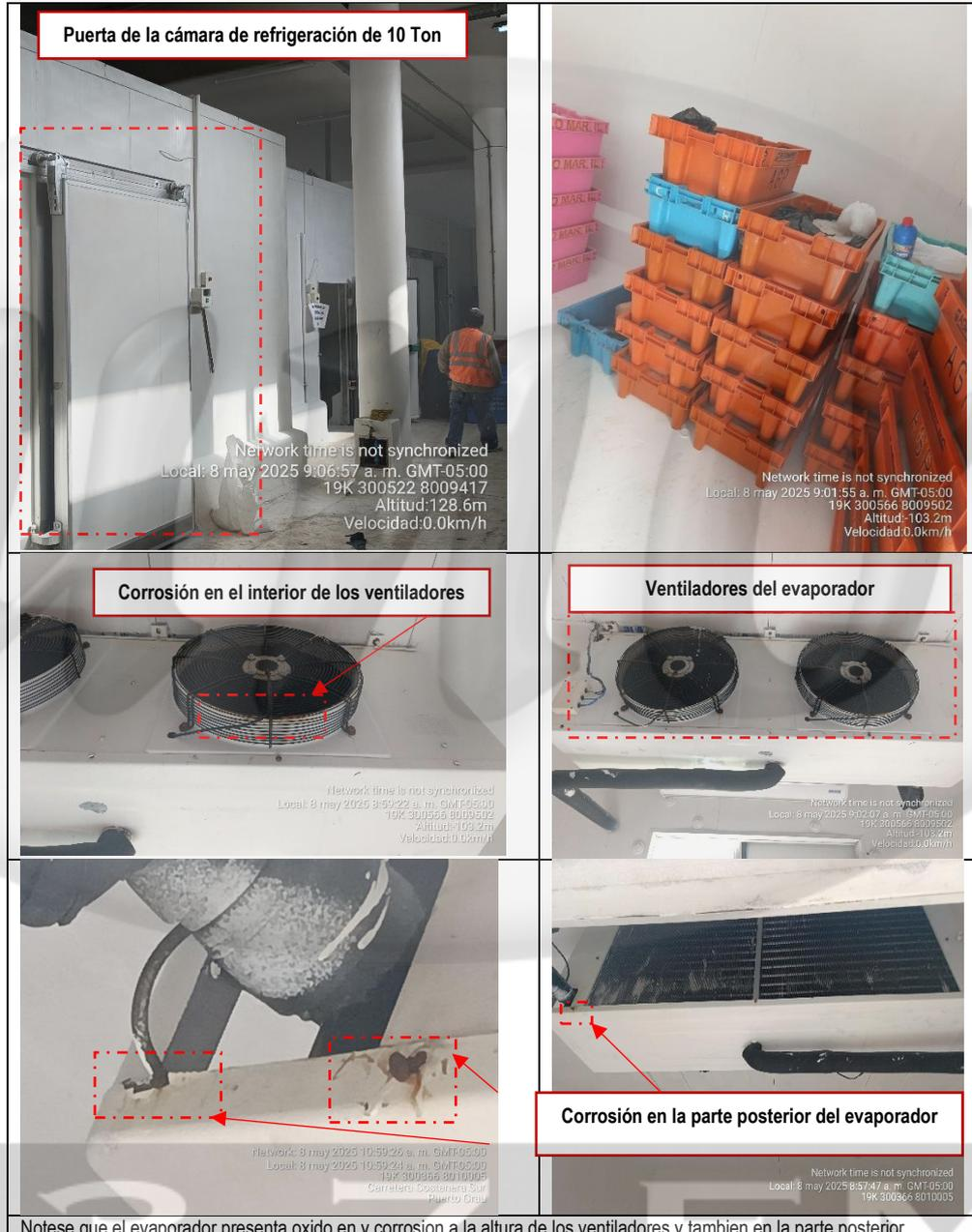
Notese que el evaporador presenta oxido en y corrosión a la altura de los ventiladores y tambien en la parte posterior
