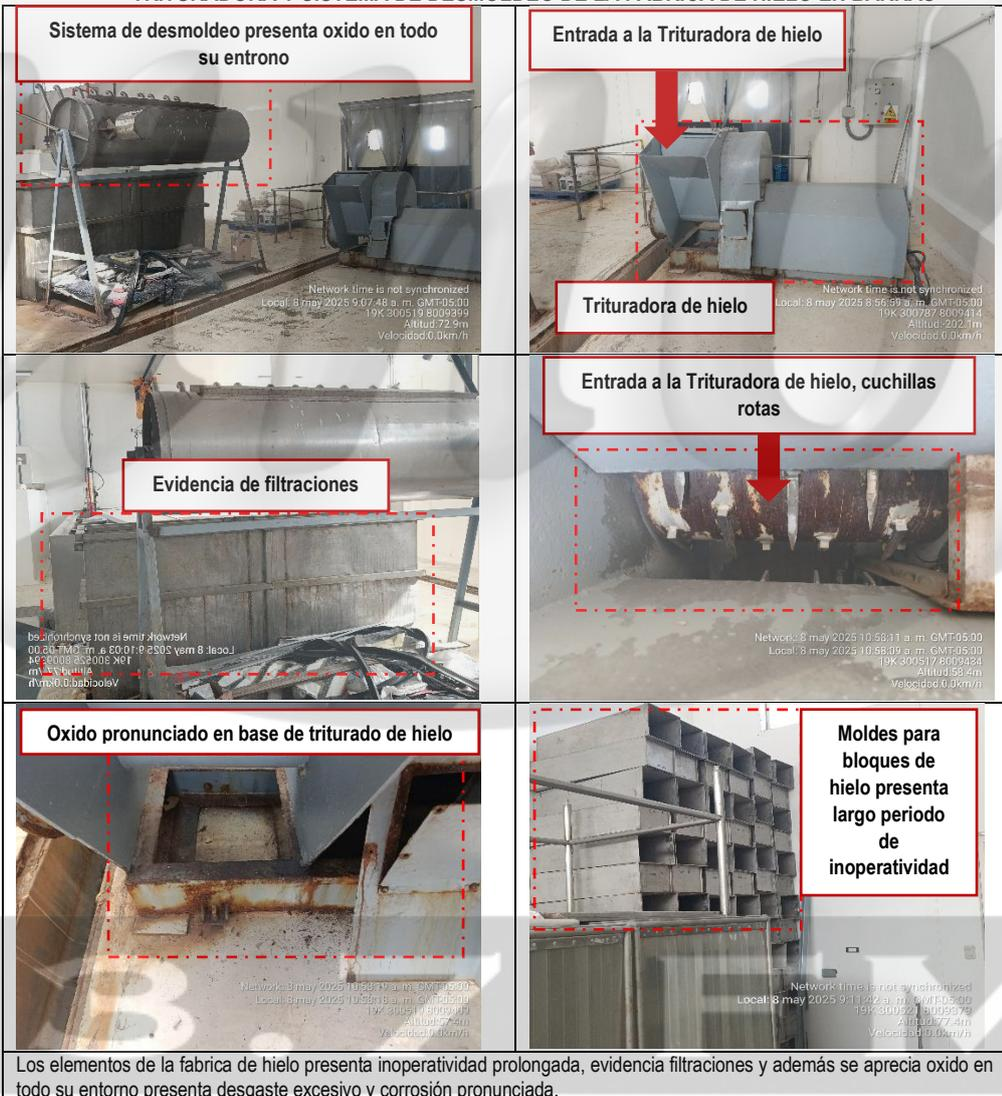
Los elementos de la fabrica de hielo presenta inoperatividad prolongada, evidencia filtraciones y además se aprecia oxido en todo su entorno presenta desgaste excesivo y corrosión pronunciada.
