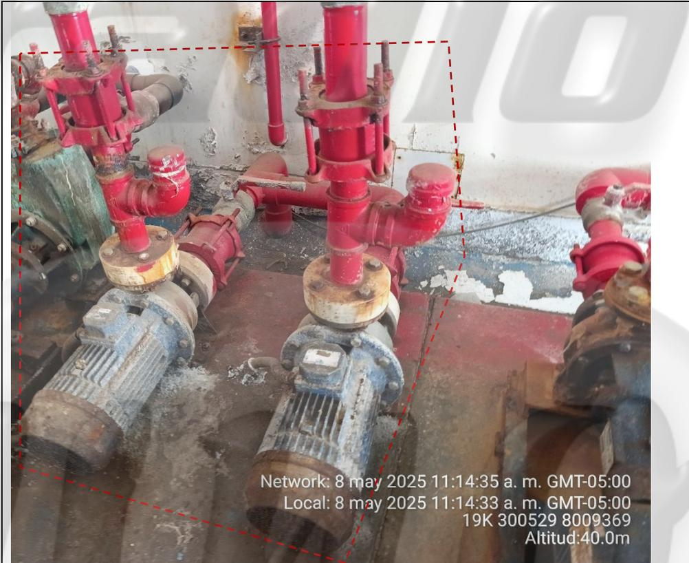
Notese, que las bombas y las tuberías evidencian corrosión excesiva en todo su entorno producto de sal, denotando falta de mantenimiento
