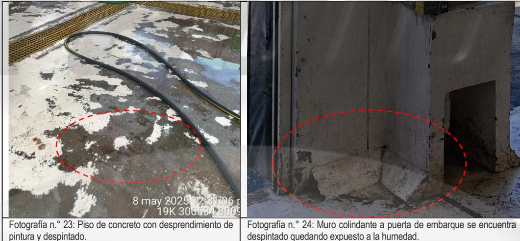
Fotografía n.º 23: Piso de concreto con desprendimiento de pintura y despintado.
