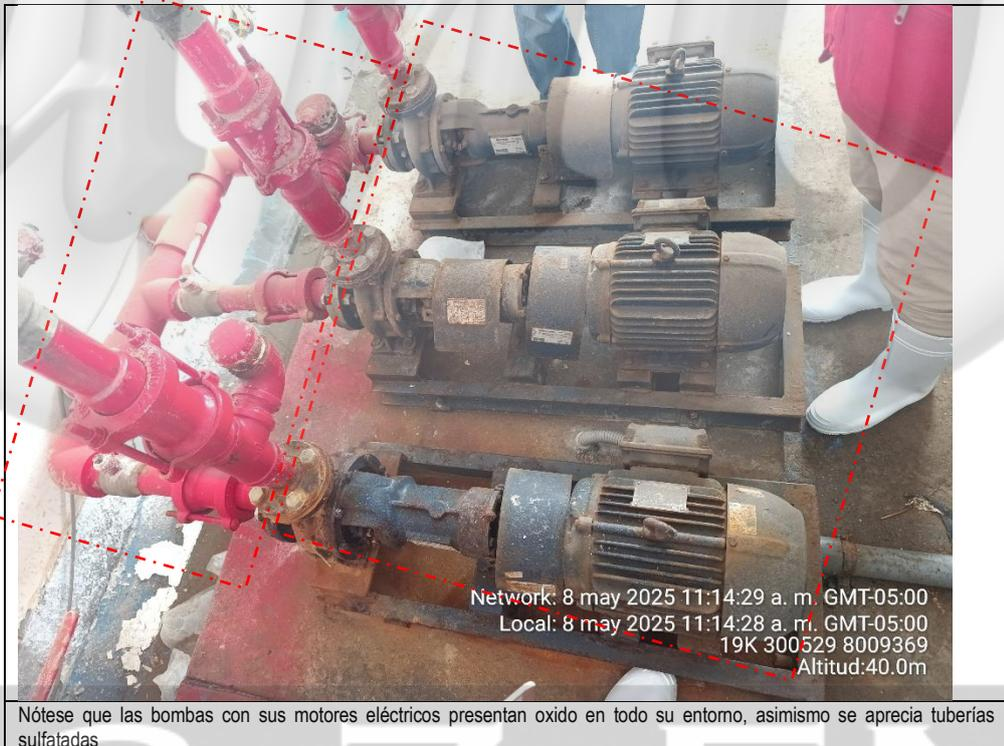
Nótese que las bombas con sus motores eléctricos presentan oxido en todo su entorno, asimismo se aprecia tuberías sulfatadas
