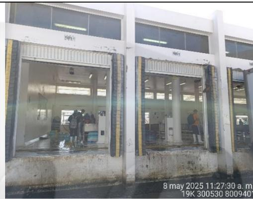
Fotografía n.º 32: Vista de puertas de embarque donde se observa el marco de jebes colocado al costado de puerta para bajar el impacto de choque.
