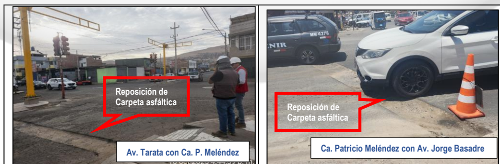
Imagen n.ºs 4 y 5 Estado Actual – Reposición de Carpeta Asfáltica
