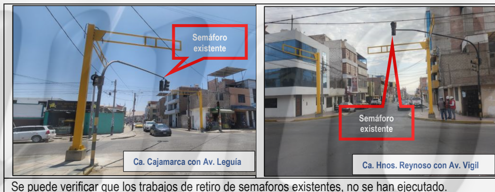
Imagen n.ºs 2 y 3 Estado Actual – Retiro de semáforos existentes
