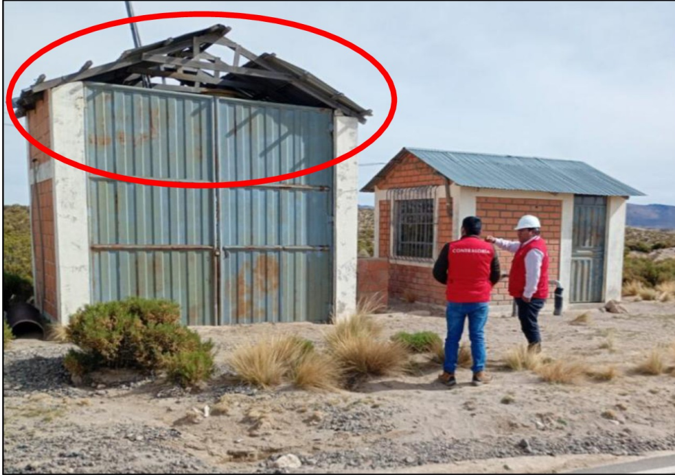
Imagen N° 1 Vista Exterior de la Caseta
