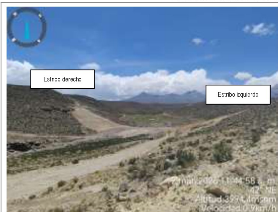
Fotografía n.º 5: Vista general de estado de excavación eje de presa estribo izquierdo, derecho y tubería temporal (corrugada de Ø 450mm)
