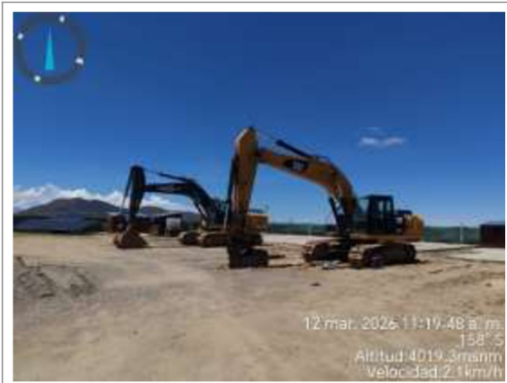
Fotografía n.º 3: Vista de equipos (excavadora hidráulica) en el campamento del Contratista.
