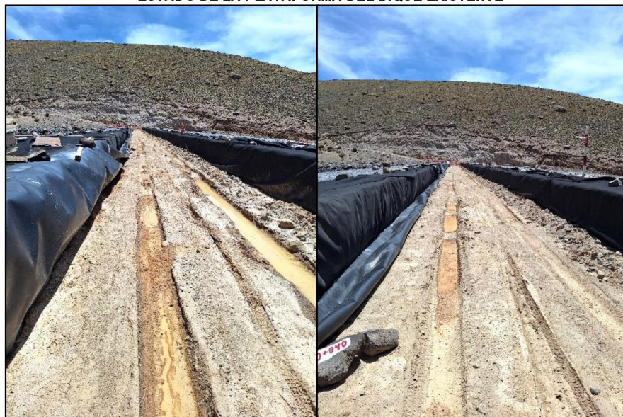
IMÁGENES N° 11 Y 12 ESTADO DE LA PLATAFORMA DEL DIQUE EXISTENTE
