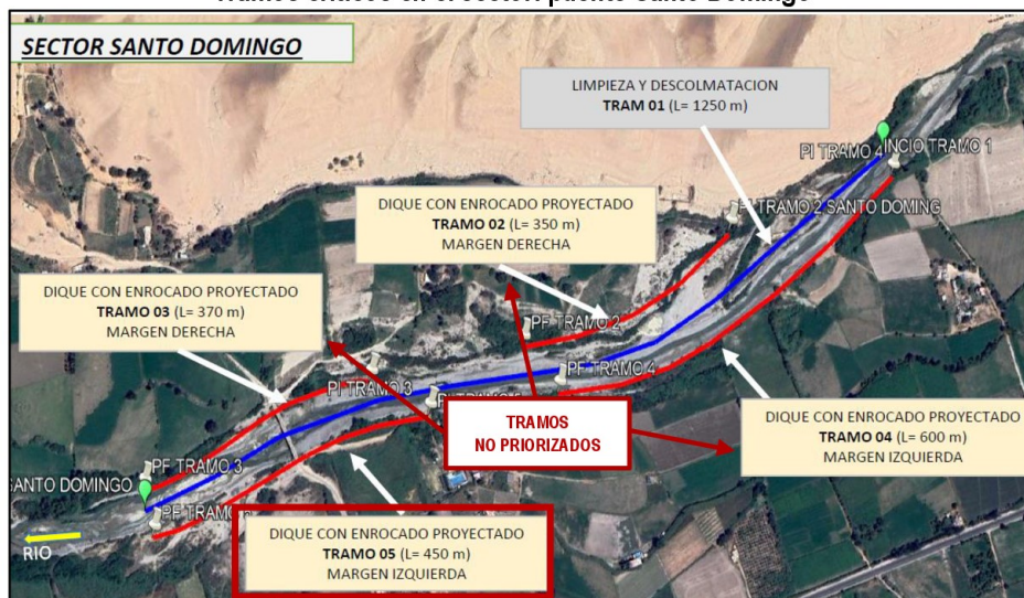
Imagen n.º 6 Tramos críticos en el sector: puente Santo Domingo
