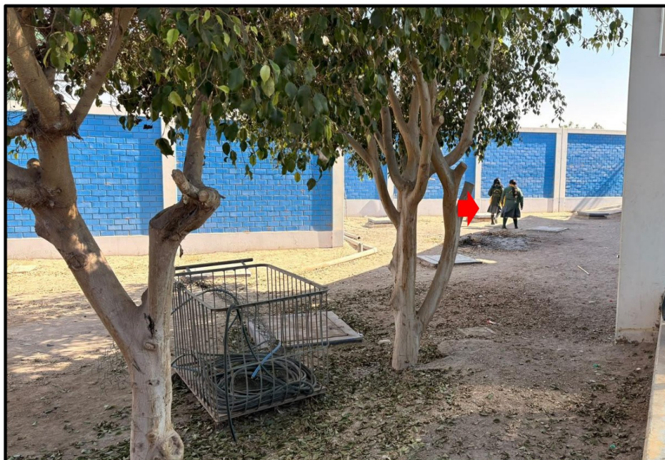
FOTOGRAFÍA N° 7 TRÁNSITO DE ESTUDIANTES SOBRE EL ÁREA DONDE SE UBICAN LOS SILO O POZOS SÉPTICOS
