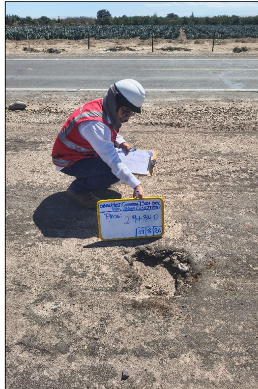
Imagen n.º 9. Imprimado sobre hueco en la progresía km 29+300
